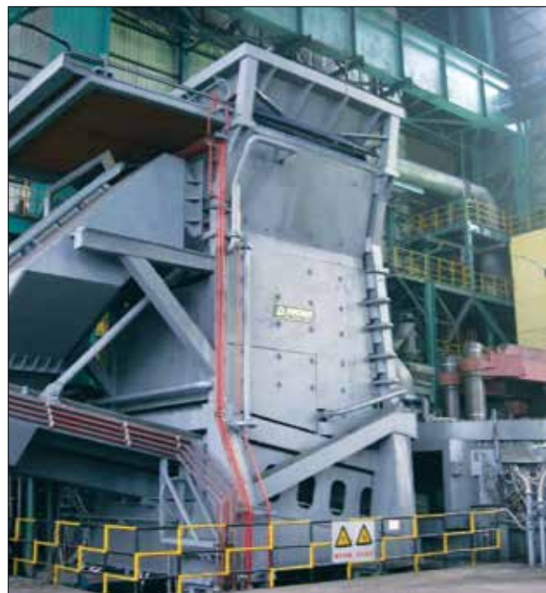
شکل ۳- تجهیزات پیش گرم قراضه در مجاورت کوره قوس الکتریکی
